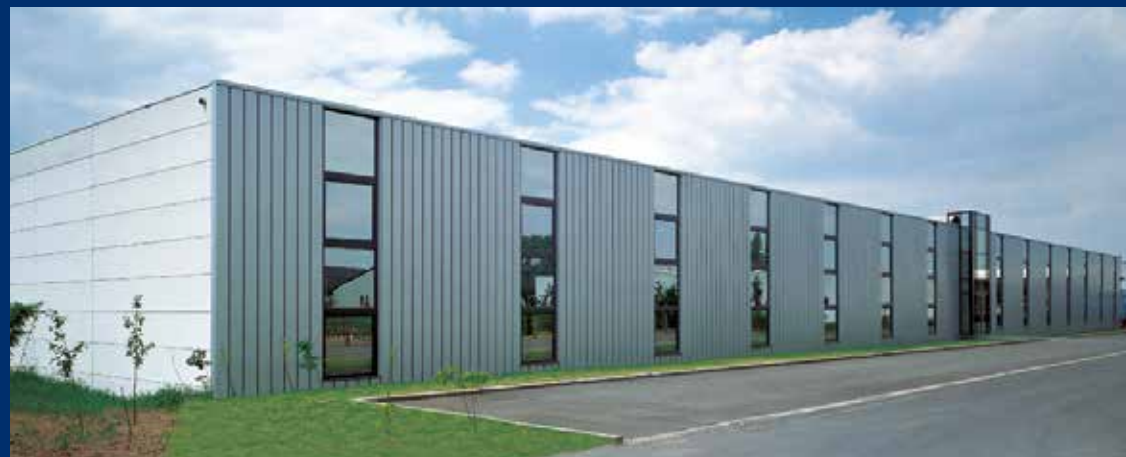
LES BÂTIMENTS DE SOCIÉTÉ À ANZEGEM
